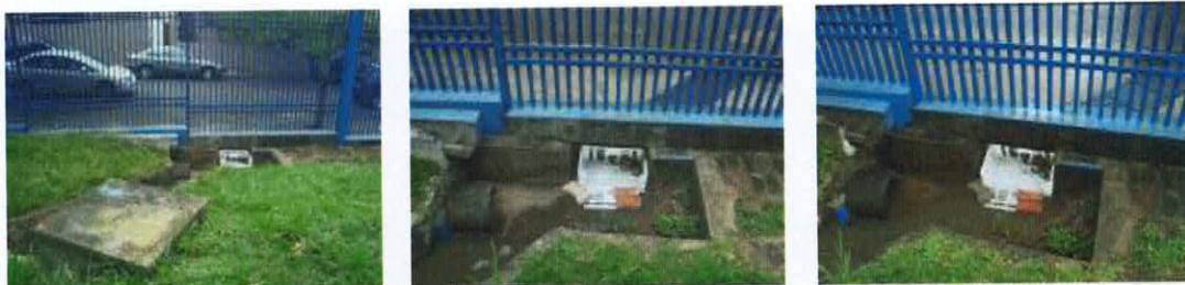
Figura 3: a) instalação das caixas; b) vista superior das caixas e fixação com arames; c) ancoragem com uso de blocos de concreto (Fonte: os autores, 2012)
