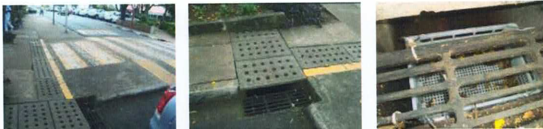
Figura 4: a) local de instalação da caixa; b) vista superior da boca de lobo; c) caixa fixada em baixo da boca de lobo (Fonte: os autores, 2012)
