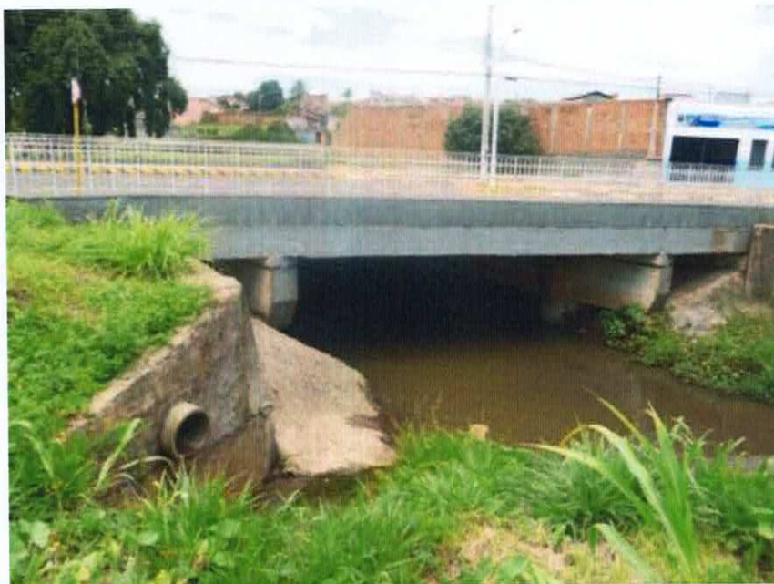
Figura 6 - Ponte da Avenida Armando Penteadado
