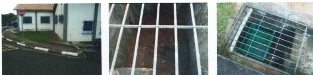
Figura 5: a) local de instalação da caixa; b) vista superior da boca de lobo; c) caixa fixada em baixo da boca de lobo (Fonte: os autores, 2012)
