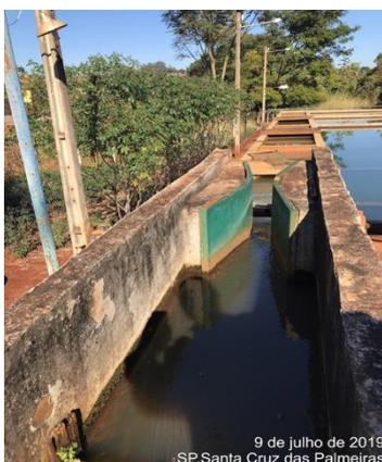
*Figura 52 – Floculador hidráulico de chicanas*
