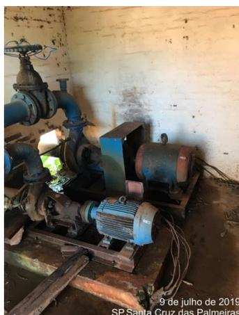
*Figura 19 - Instalações elétricas de acionamento elétrico dos conjuntos moto bombas*
