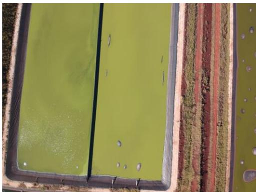
*Figura 128 – Detalhe de bolhas na manta de impermeabilização da Lagoa de Maturação*
