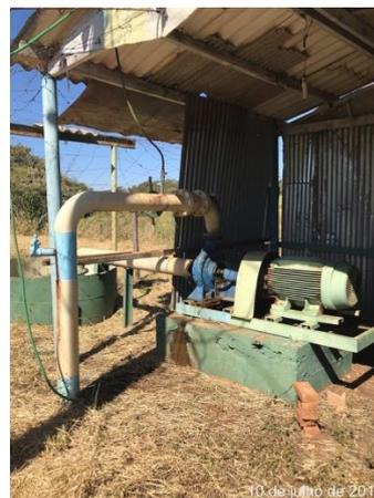
Figura 34 – Instalações elétricas de acionamento de conjunto moto bomba
