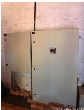
Figura 114 – Painel de Acionamento – EEEB-Final
