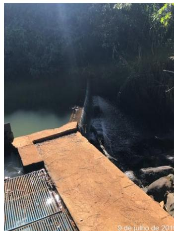
*Figura 22 – Captação de surgência (mina) – Aurora. Detalhe de barramento*
