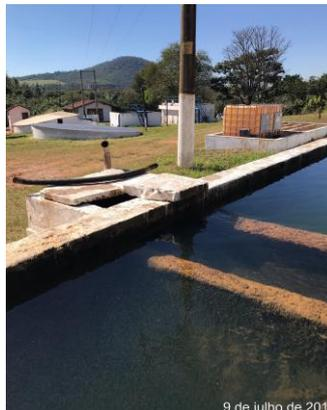
*Figura 67 – Vista lateral da ETA – Flculador e decantador*
