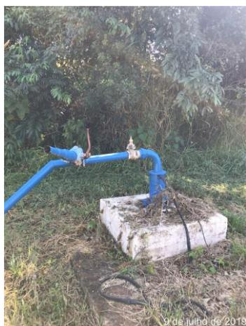
*Figura 25 – Captação por poço profundo – Poço 2*
