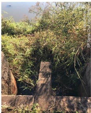
Figura 15 - Sistema de tomada de água não concluído
