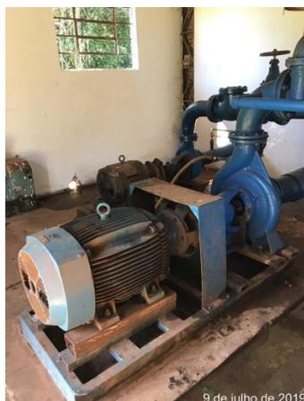
Figura 29 – Conjunto moto bomba 2 de recalque de água bruta
