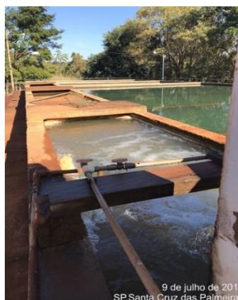
*Figura 53 – Decantador de fluxo horizontal*
