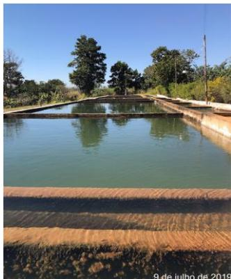
*Figura 66 - Saída de água decantada. Decantador afogado e arraste de flocos*
