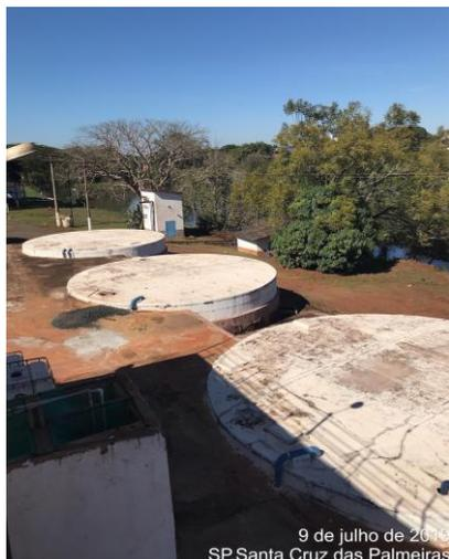
Figura 90 – Reservatório desativado 1.000m<sup>3</sup>
