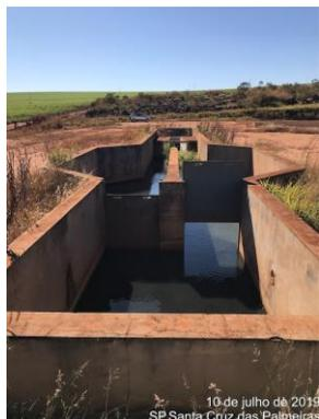
Figura 122 – Entrada de efluente bruto – Lagoa Anaeróbia
