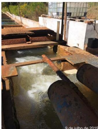
*Figura 64 - Floculador hidráulico de chicanas verticais*
